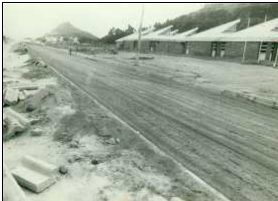
Figura 14 – Obras na Av. Leitão da Silva próximo a EEEFM Des. Carlos Xavier P. Barreto Fonte: Acervo IJSN – Década de 1970
