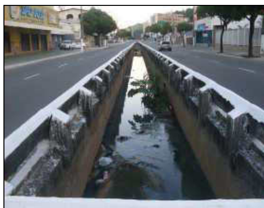
Figura 23 – “Valão” da Av. Leitão da Silva – Dias atuais. Trecho entre as saídas das Ruas Dr. Eurico de Aguiar e Arnaldo Magalhães Filho. Fonte: Foto do Autor – Novembro de 2012
