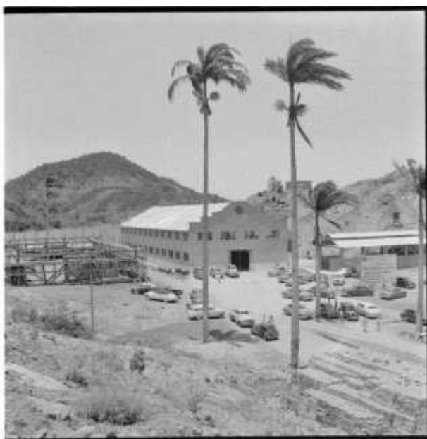
Figura 12: Construção dos Galpões da Casa de Máquinas [1954] Fonte: Arquivo Público Estadual
